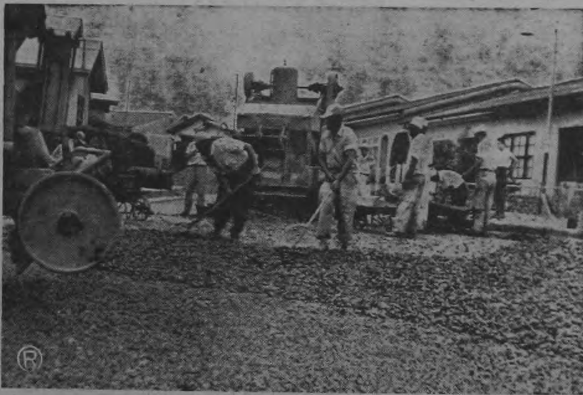
Cuadrillas y equipos municipales que en la Ciudadela Calderón Muñoz hacen el asfaltado de nuevas calles y reparan las viejas con un costo total de ₡ 100.000.00 de los cuales el INVU aporta ₡ 60.000.00
