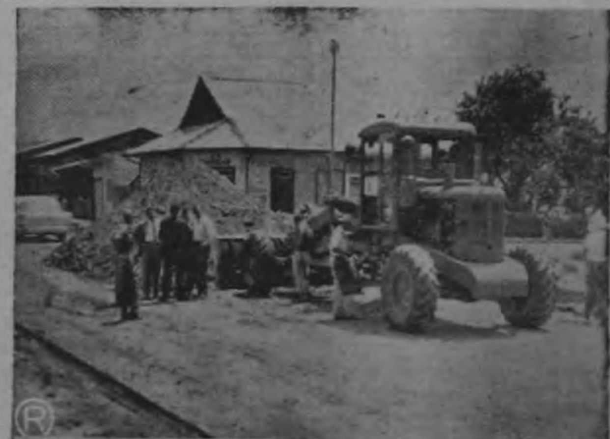
En la calle 20 Sur, entre carretera a Alajuelita y avenida 32, la motoniveladora municipal prepara la vía que va a ser asfaltada y en la cual se instaló ya nueva cañería.
